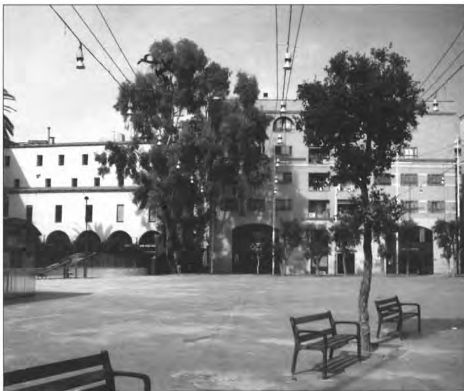
Exemple del pla d'actuacions integrals al districte de Ciutat Vella de Barcelona. Lloc: Plaça de les caramelles. Habitatges de reinstal·lació de famílies que vivien en els antics edificis enderrocats. Guarderia municipal als baixos del rehabilitat Convent dels Àngels. Nou espai públic i, a sota, un aparcament soterrani.
