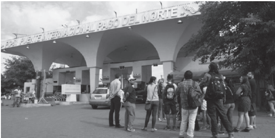
Figura 19. Entrada del Puente Internacional Paso del Norte
