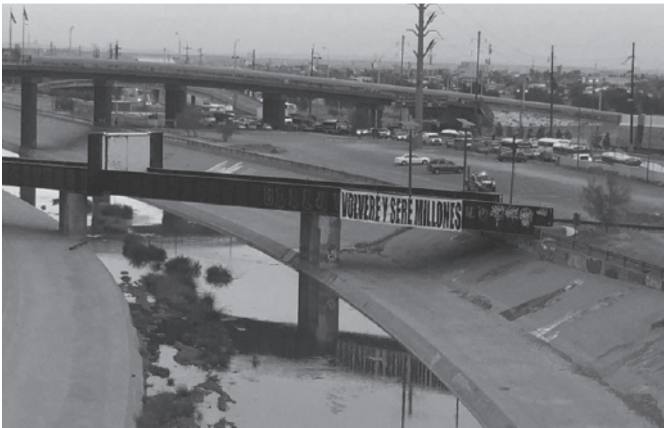
Figura 14. Instalación «Volveré y seré millones» en el «Puente Negro»
